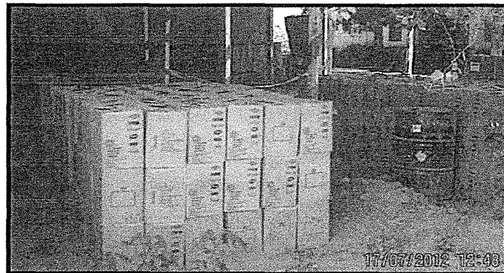
Se observa que el Área de Almacenamiento de Sustancias Químicas no cuenta con las especificaciones técnicas del artículo 44° del D.S. N° 015-2006-EM
