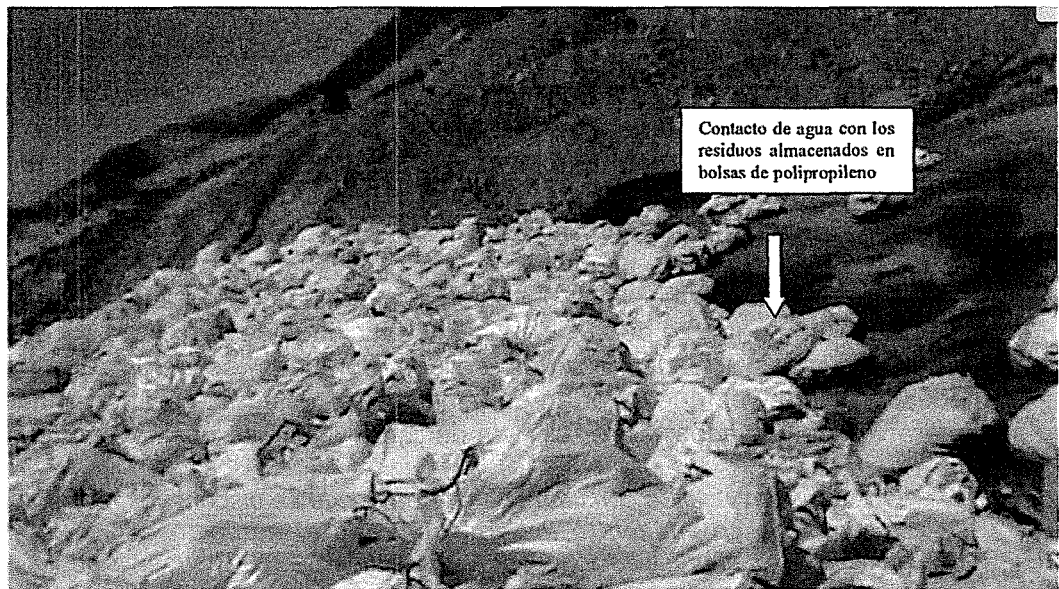
Fotografía N° 12: Se puede apreciar la humedad del suelo debajo de la disposición de residuos
