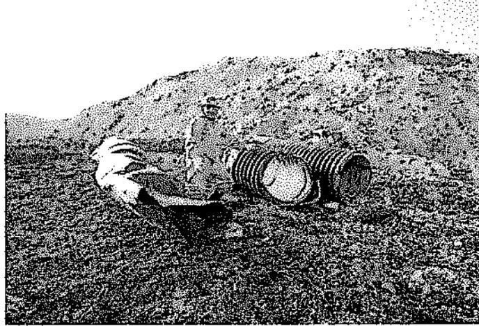
FOTO N° 6: Tuberías corrugadas en desuso (residuos sólidos) en la parte baja del depósito de desmonte La Quinua lado Sur Oeste, por donde se están construyendo canales para aguas de escorrentías, dispuestos sobre un área no adecuado para tal fin.
