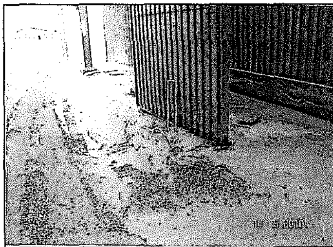
Foto 2-14.22: Presencia de relaves derramados en una de las puertas laterales de la planta concentradora, por fallas en el sistema de flotación.
