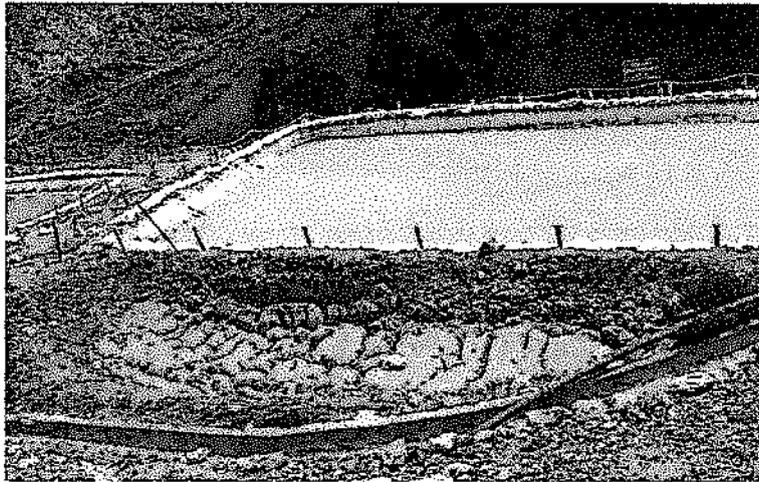
Fotografía N°1: Observación N°1: Junto a la poza de sedimentación N° 2, ubicada próxima a la Rampa, Don Enrique hay una poza con lodos (que forma parte del componente) que no han sido retirados y están secos. Esta poza no tiene recubrimiento interno ya que los lodos están en contacto con el suelo.
