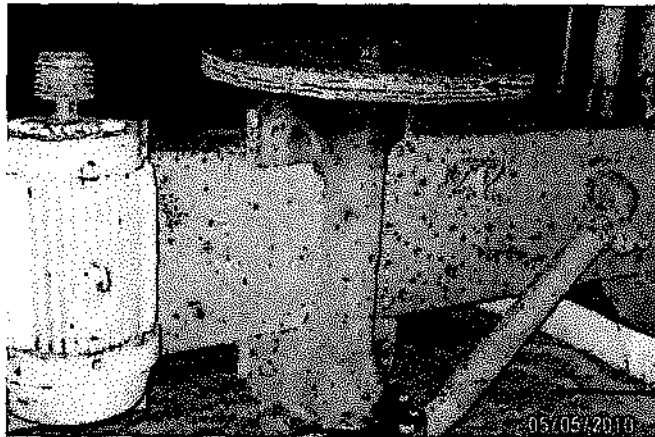
Foto 1: La faja de la polea del motor de inyección de aire (aireador) se encuentra sin conectar, dejándolo inoperativo.
