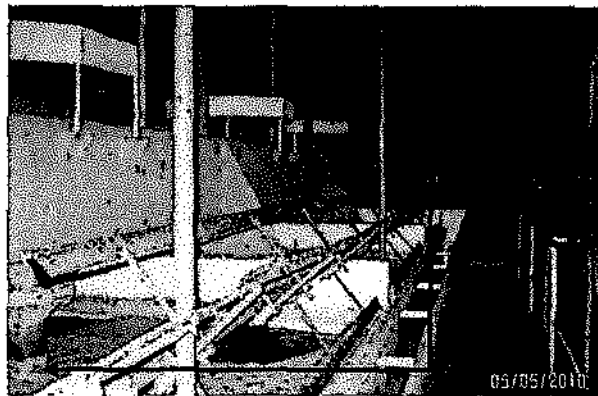
Foto 4: Las paletas de la celda de flotación no recuperan la espuma y grasa por falta de nivel de agua en la celda.
