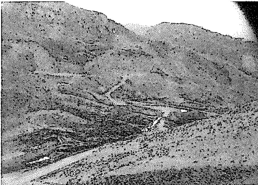
Fotografía N° 41: Nuevo depósito de desmontes Rumiallana, se observa el deslizamiento del talud de la base de la quebrada, por la ejecución de trabajos en la zona, no se han ejecutado obras de remediación, UEA Cerro de Pasco.
