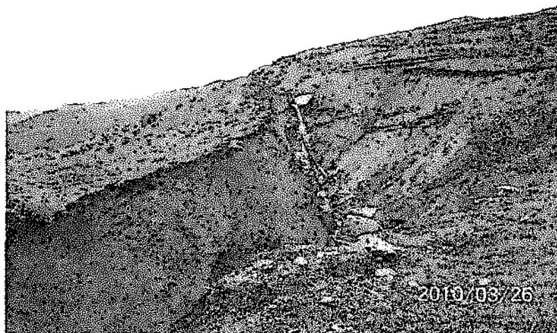
Fotografía N° 32 Canal de coronación en la margen izquierda de la quebrada Rumiallana, el cual ha colapsado y las aguas han erosionado la ladera impactando el bofedal ubicado en el lecho de la quebrada, UEA Cerro de Pasco.
