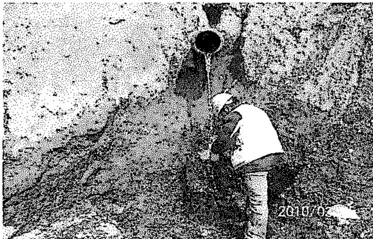
Fotografía N° 111: Descarga de aguas acidas a nivel de la Ex planta de Cátodos directamente a canal circundante de la margen izquierda de la presa de relaves Quiulacocha, UEA Cerro de Pasco.
