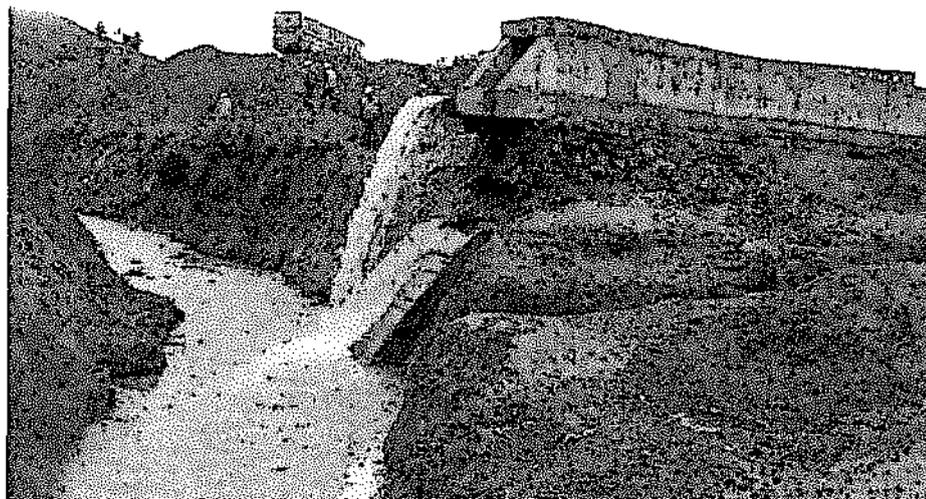
Fotografía N° 114: Canal de evacuación de aguas ácidas, posiblemente de mina, de estación de bombeo Winze 98 directamente a afluente del río San Juan, UEA Cerro de Pasco.
