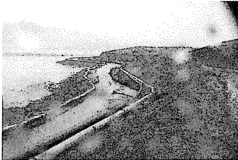
Fotografía N° 84: Canal de conducción de lodos de planta de neutralización de aguas ácidas sobre terreno natural y encimado con sacos metaleros llenos de arena, en antigua vía de acceso, al costado se observan las líneas de conducción de relaves hacia la presa Ocroyoc, UEA Cerro de Pasco.
