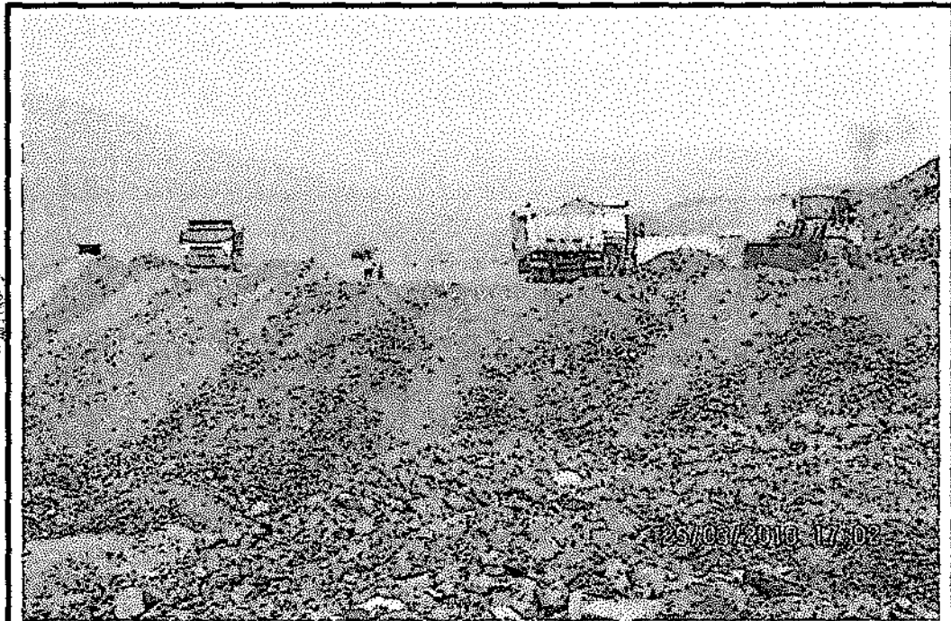
Fotografía 15. Equipos y personal trabajando en el Botadero de desmontes Alumbre Este con coordenadas (N 9°115.724.0; E823.210.0).
