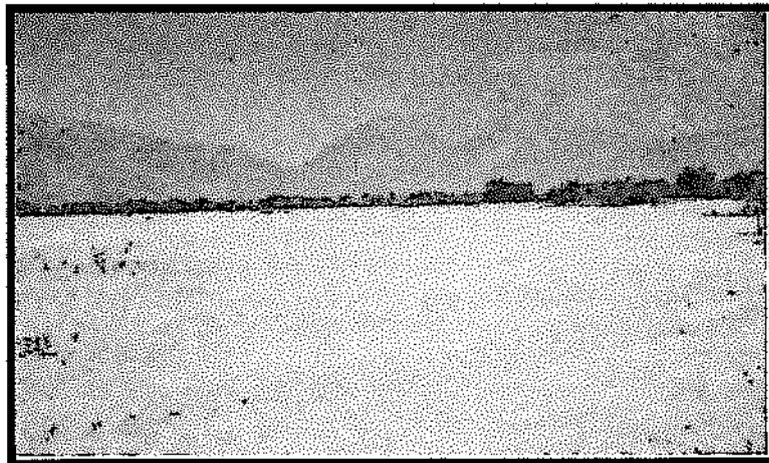
FOTO N° 2: Parte superior de la cancha de relaves N° 1, donde los relaves se encuentran sin cobertura y no se encuentran compactados, por lo que el viento arrastra las arenas muy finas y partículas pequeñas (lamas), contaminando la atmósfera y las zonas aledañas.
