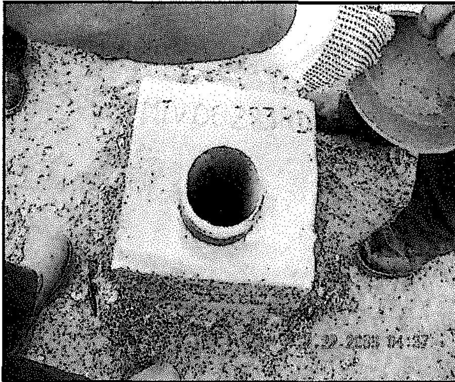
Foto N° 16: Zona 2. Dado de concreto con su respectiva identificación del sondaje realizado, efectuadas con equipo de perforación con circulación reverso y diamantina. La nomenclatura del sondaje es MJV-06-283-RD, Coordenadas UTM: 8323601N, 494237E, 783msnm. Ejecutada en el año 2006. Obsérvese que la tapa del sondaje no está sellada.
