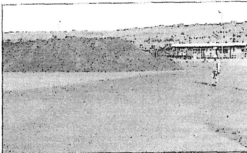
Fotografía C-27: En el área de almacenamiento de concentrado en Patio Puerto, se observa el área de salida de vehículos con dispersión de concentrados hacia los suelos no contando con un sistema de limpieza de neumáticos que evite la dispersión de concentrados fuera de esta área, asimismo en el área colindante a la línea del ferrocarril presenta una marcada dispersión de concentrado.
