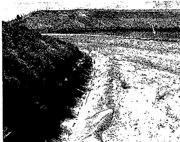
Fotografía 46: Canal de Coronación de la Poza de Grandes Eventos, previo a la descarga a las laderas de la margen derecha del río Chacapalca, sin evidencia de descarga o flujo de agua
