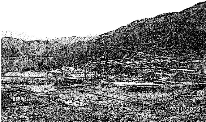
Foto N° 20b: Otra vista del transporte de relaves mediante una tubería HDPE desde la planta concentradora al depósito de relaves.
