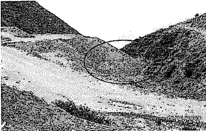
Foto N° 76: Verificación Recomendación 01-2008. En el pie del talud del depósito de desmorte NV 3250; se observa que la quebrada 3250, aún está cubierta con desmorte, no se ha cumplido con dejar libre la quebrada en mención.
