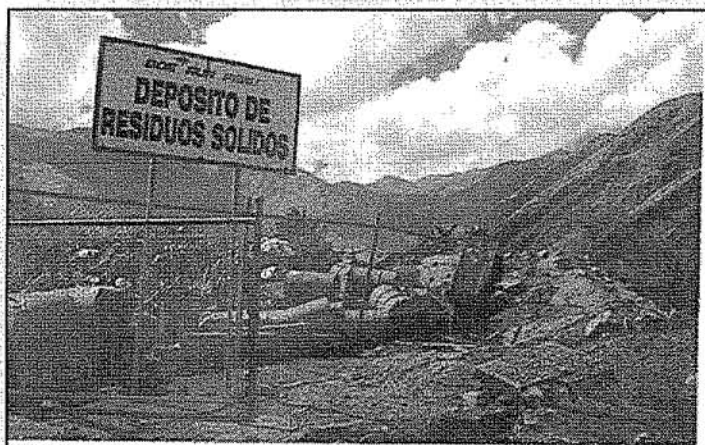
Fotografía N° 15.- Cerco perimétrico del depósito de RR.SS. se observa el cerco incompleto y no ofrece medidas de protección .
