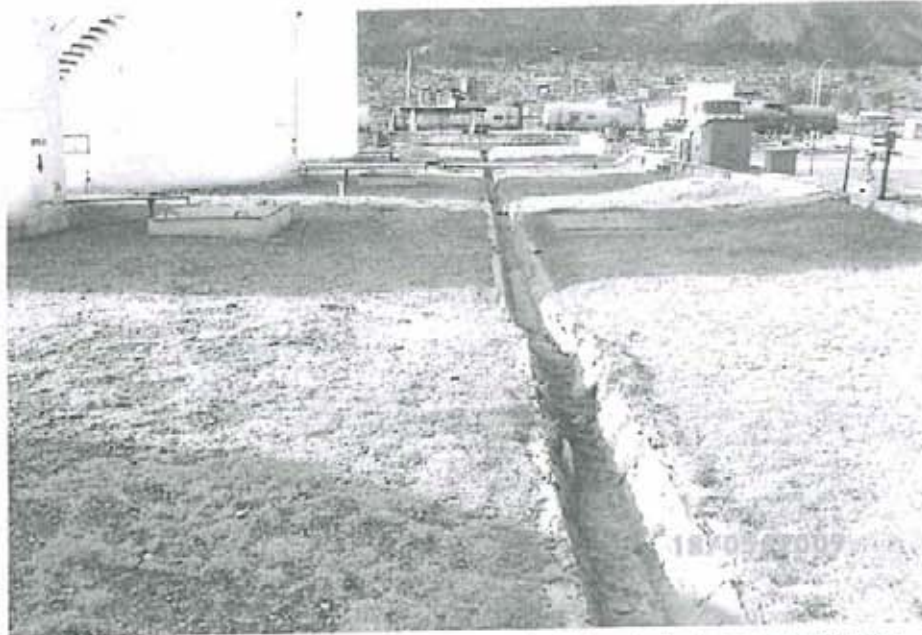
Figura N° 13. Se muestra la poza ciega de recolección del drenaje de tanque en recipientes.
