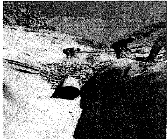
Foto N° 8: Relleno de la tubería de sub drenaje manual.
