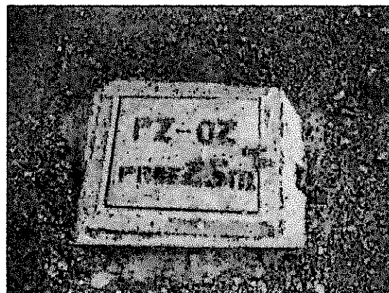
Foto N° 2b: Instalación de Piezómetro PZ - 02, ubicado de la parte baja de los Pads de lixiviación.
