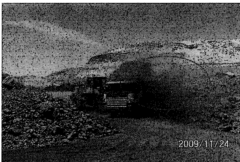
Fotografía 40: Falta mejorar el control de polvo fugitivo en el carguío de camiones en depósito de mineral en chancado primario, recomendación N° 9 supervisión regular 2009, no cumple con la recomendación N° 5 139 de la Supervisión Regular 2008. El sistema implementado que consta de aspersores y mangueras es ineficiente.
