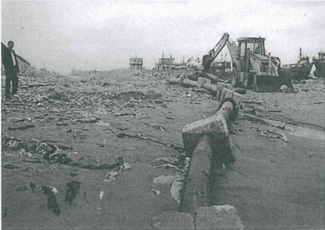
Se observa la parte final de la tubería, enterrada y obstruida por efecto del arenamiento en la línea de la marea alta, orilla de playa.
