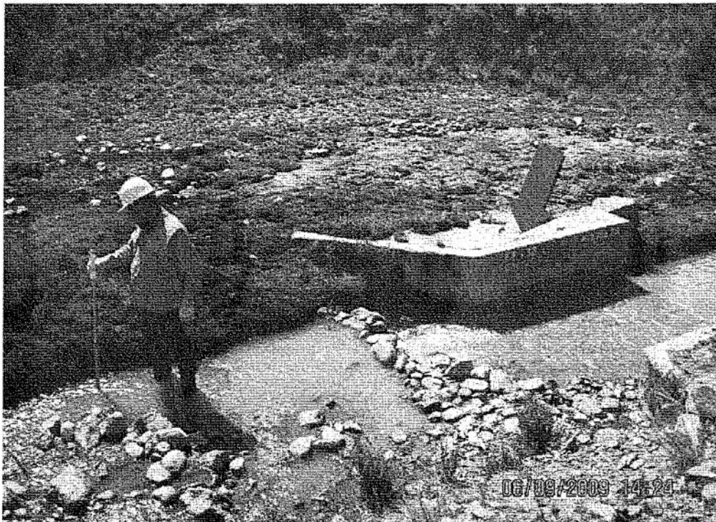
Foto 7. Punto de monitoreo E-02 (EF-12). Medición del flujo del efluente de la presa San Felipe
