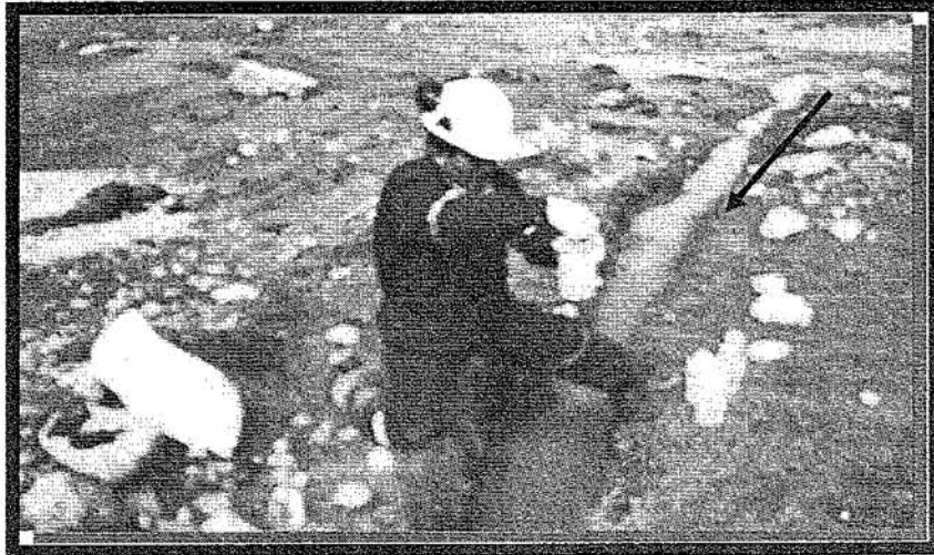
FOTO N° 48: Canal de infiltración en suelo natural de efluente doméstico tratado.
