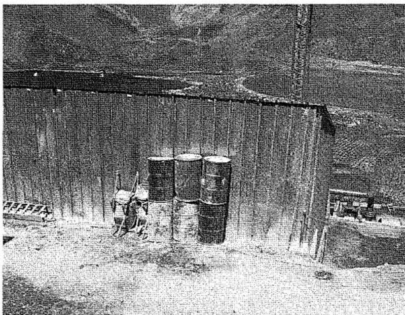
FOTO N° 07: EN LA PARTE EXTERNA DE LA PLANTA CONCENTRADORA BERNA II, SE OBSERVÓ ENVASES VACÍOS DE SUSTANCIAS TÓXICAS (REACTIVOS USADOS EN PLANTA: XANTATOS Y ESPUMANTES) EN UN ÁREA NO DESTINADA PARA TAL FIN, Y COLOCADOS SOBRE TIERRA.
