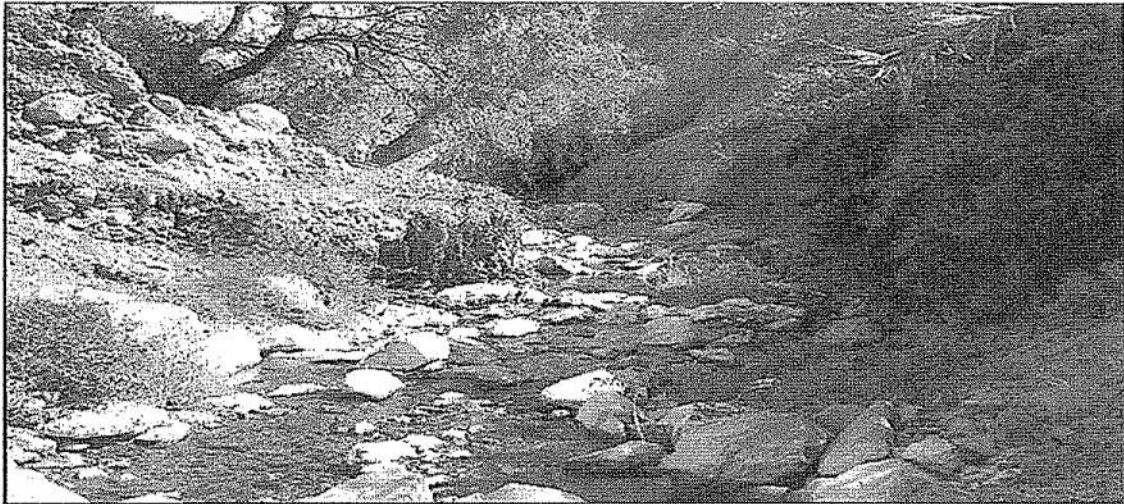
FOTO 9. CH Aricota I: Erosión de las márgenes del río Curibaya, por la descarga del Canal de Alivio de la cámara de carga de la CH Aricota I.
