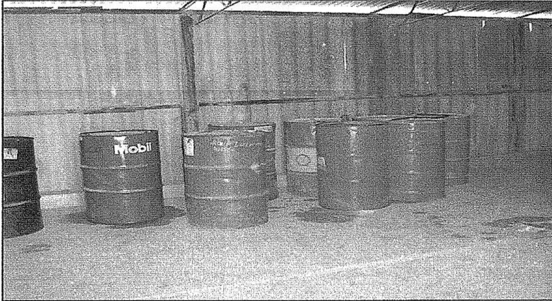
FOTO 12. CH Aricota II: Cilindros con residuos de aceite dieléctrico, no caracterizados, que según el personal de EGESUR podrían contener PCBs.
