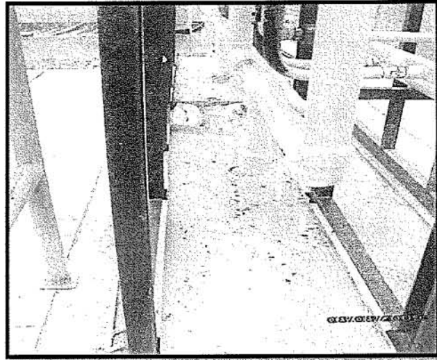
Fotografía N° 03.- Bandejas a donde cae el goteo condensado, en una de ellas se observa la salchicha para absorber el condensado.
