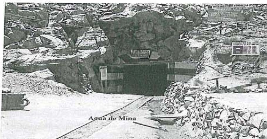
Vista N° 47.- Efluente proveniente de la bocamina Cachi Cachi. Actualmente la bocamina no está en operación, solo se utiliza como acceso.
