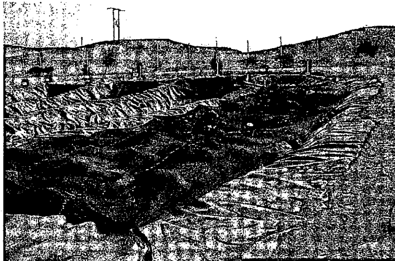
Fotografía 46: Operación del actual relleno sanitario sin existencia de chimeneas
