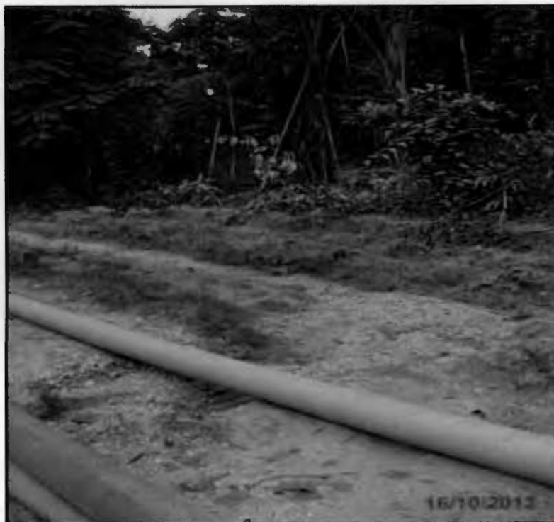
Fotografía N° 27 del Informe N° 219880-2012-GFHL-UPPD: Con esta vista se puede observar la cercanía de las tuberías en mal estado junto al inicio de la quebrada Shanshococho.
