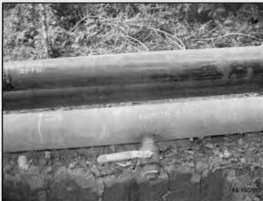
Fotografía N° 23 del Informe N° 219880-2012-GFHL-UPPD: Vista de la línea de flujo del Pozo CS20 de reinyección del agua de producción con una válvula de 2" y una tubería nueva para el cambio de tramo.
