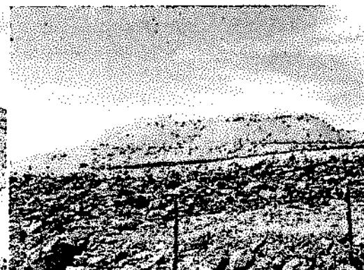
Fotografía 4. Taludes de la Cancha de Desmonte estabilizados y con cobertura de arcilla
