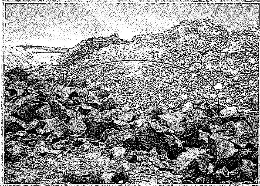
Fotografía N° 62: Recrecimiento del depósito de desmonte sobre terreno natural sin acondicionamiento, obsérvese la zona de roquedales hábitat de la especie vizcachita ( Lagidium viscacia ), Recomendación N° 5, U.O. Ares.
