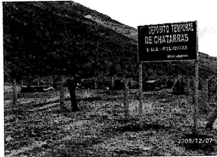
Cerco perimétrico y letrero de identificación
