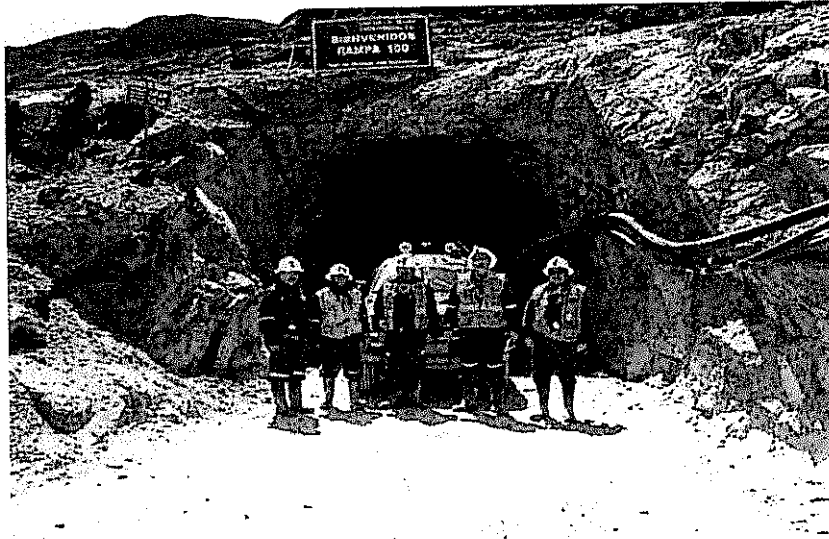
FOTO 1.8: Obs N° 8 (2009) Rampa 100 avanzado para acceder a las vetas matabalho y saca si puedes en espera de la aprobación del respectivo EIA para iniciar la producción
