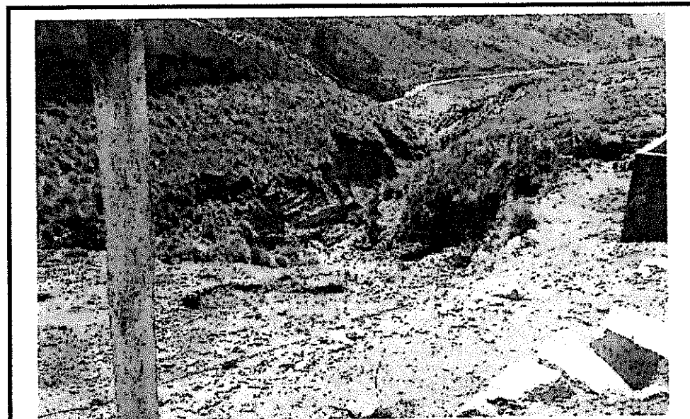
Foto N° 17.- Quebrada Tallas: el agua colectada en la poza de sedimentación (agua de subdrenes del Depósito de Relaves) es vertida directamente hacia la quebrada. Esta agua debería ser recirculada a la Planta Concentradora pero actualmente está sin operar. Las aguas del canal de coronación de la relavera también son vertidas en esta quebrada.
