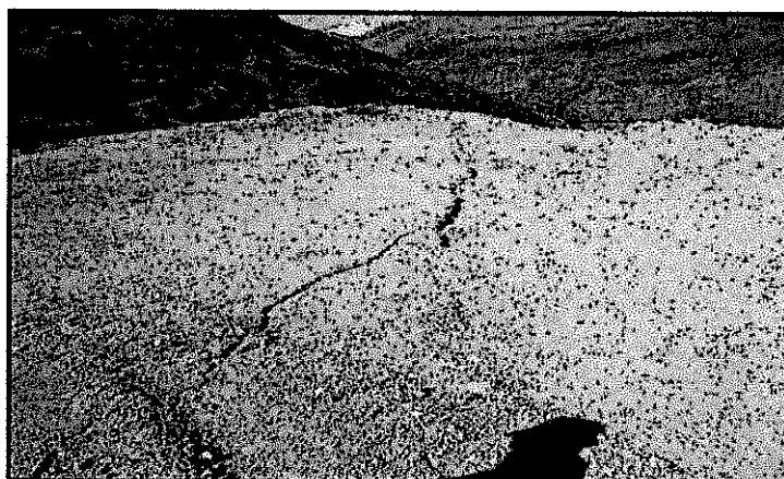
Foto N° 18: Parte superior del tajo Santa Rosa que presenta grietas o rajaduras bien pronunciadas, que ponen en peligro dicho tajo, situado en la Unidad Minera “Andes 1”.
