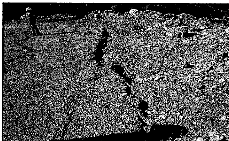
Foto N° 19: Otra vista de la parte superior del tajo Santa Rosa que presenta grietas o rajaduras bien pronunciadas, que ponen en peligro dicho tajo, situado en la Unidad Minera “Andes 1”.
