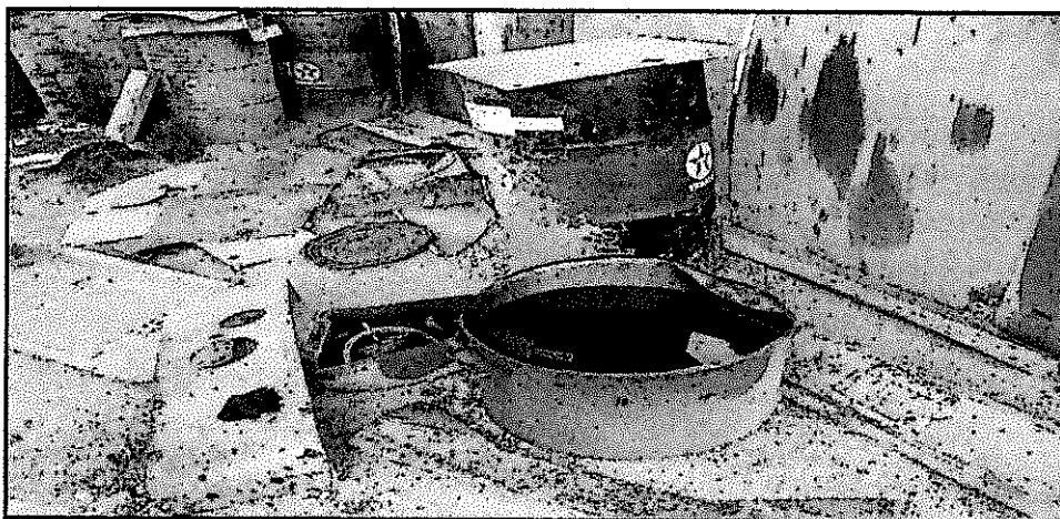
Foto N° 13: Depósito con aceites usados dispuestos sobre suelo natural y sin protección, situado en el Taller de Mantenimiento de Equipo Pesado de la Unidad Minera "Andes 1".
