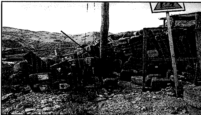
Foto N° 17: Depósitos vacíos de ácido clorhídrico (residuo peligroso) a la intemperie, dispuestos sobre suelo natural y sin protección, situado en la Planta de Beneficio de la Unidad Minera "Andes 1".
