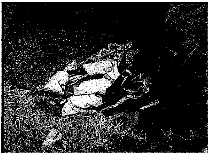
Foto N° 25: Otra vista de los residuos sólidos domésticos regados, sin cubierta de tierra, dispuestos inadecuadamente sobre una trinchera sin geomembrana.
