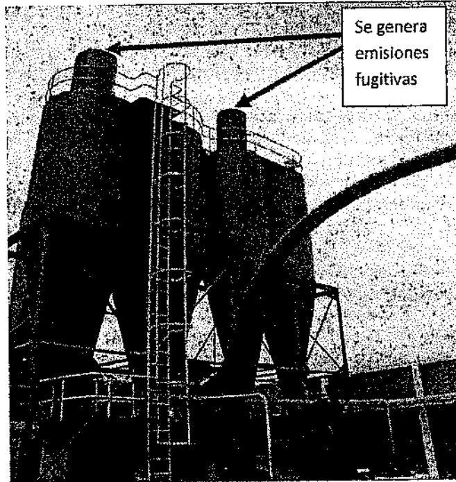
Lavador de gases a chorro de agua que no fue implementado para mitigar las emisiones generadas en los ciclones de los secadores directos.
