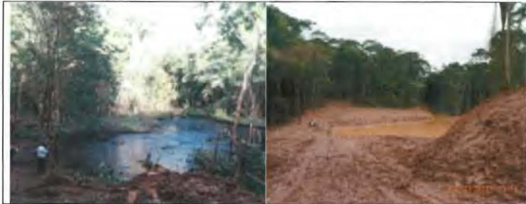
Antes de la intervención
