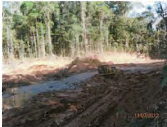
Fotografía N° 2 del Informe de Supervisión N° 692-2012-OEFA/DS: Vista de los trabajos de rehabilitación de la laguna Shanshocochoa, ubicada en Capahuari Sur, mediante el método Landfarming (Coordenadas UTM – Sistema WGS 84: 030491E, 9692282).
