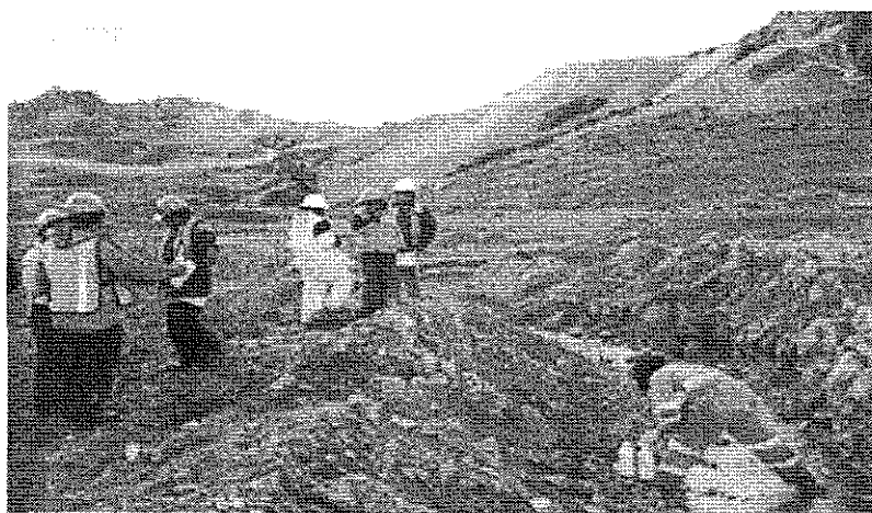
Fotografía N° 09: Toma de muestra del ST-05: Punto de monitoreo ubicado a 100m aprox. De la salida de la poza de sedimentación N° 05.
