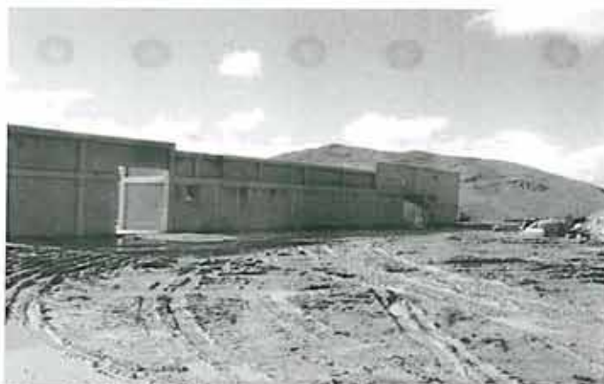
Fotografía N° 38: Sector Huisamarca, construcción sin techo, no es parte de ningún componente del proyecto de exploración.
