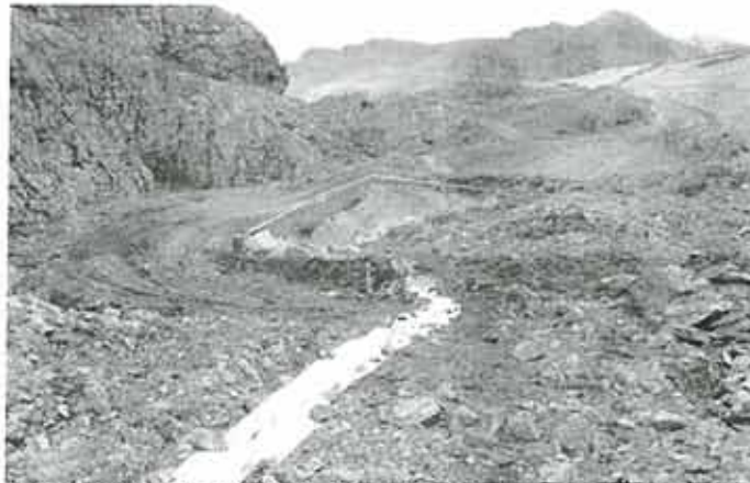
Fotografía N° 15: Condiciones existentes en la plataforma de perforación del Cerro Utunsa.
