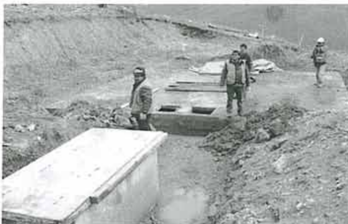
Fotografía N° 4: Construcción del Sistema de Tratamiento de Aguas Residuales Domésticas del Proyecto de Exploración Anabi.
