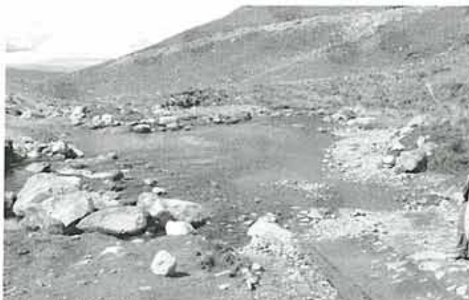
Fotografía N° 11: Vía de acceso sin alcantarillas.
