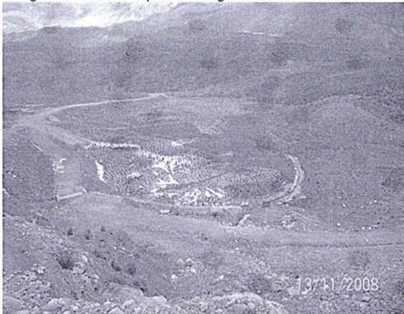
Depósito de Relaves Nieve Ucro, se observa acumulación de agua dentro del depósito.
