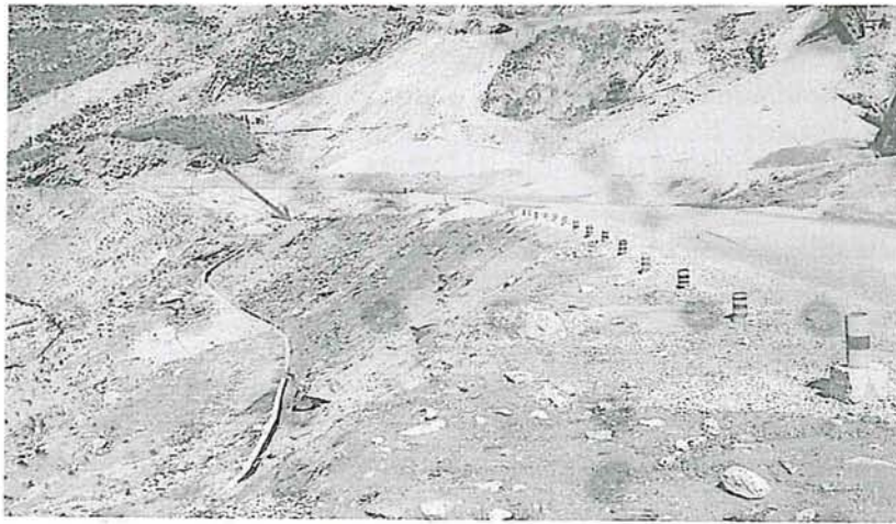
Fotografía N° 22.- Canal inferior al borde de la vía que requiere ser extendido para cubrir el área de depósitos de relaves JIG.
