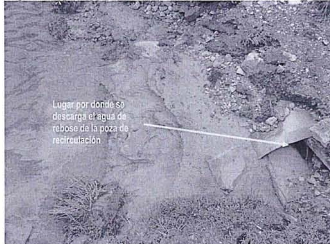
Fotografía N° 39: Descarga del rebose de la poza de recirculación hacia la Laguna Caballococha
