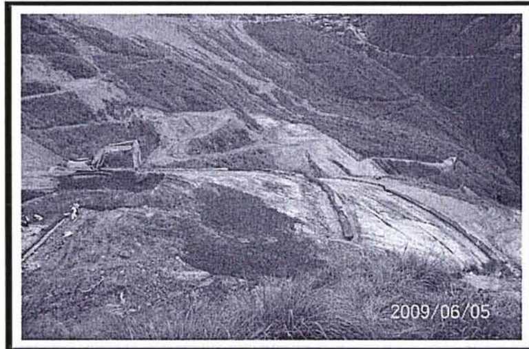
Foto 14. Depósito de Relaves 2, sin cobertura de geomembrana; se aprecia hasta 2 niveles de gavión, se ha modificado el número de niveles de éstos de 4 a 3. En la parte alta (plataforma) el retroexcavador en plena construcción del canal de conducción.
