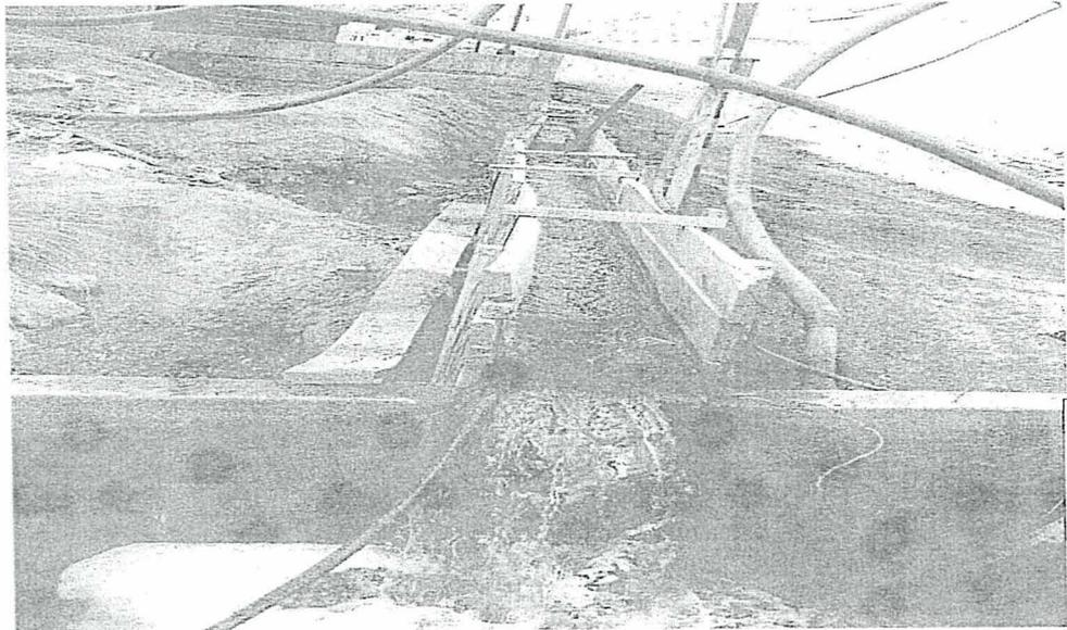
**Fotografía N° 22:** El titular minero deberá reemplazar el canal de madera ubicado entre el tranque (Bomba 20) y las cochas de mineras por un material impermeable.
