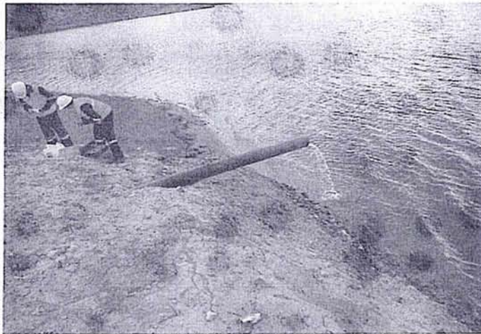
Foto N° 9: Tubería de salida de las aguas tratadas (aguas decantadas de relaves y aguas servidas) de las pozas de tratamiento Weilhand hacia la laguna Yanacocha, que falta regularizar su cambio ante la autoridad competente.
