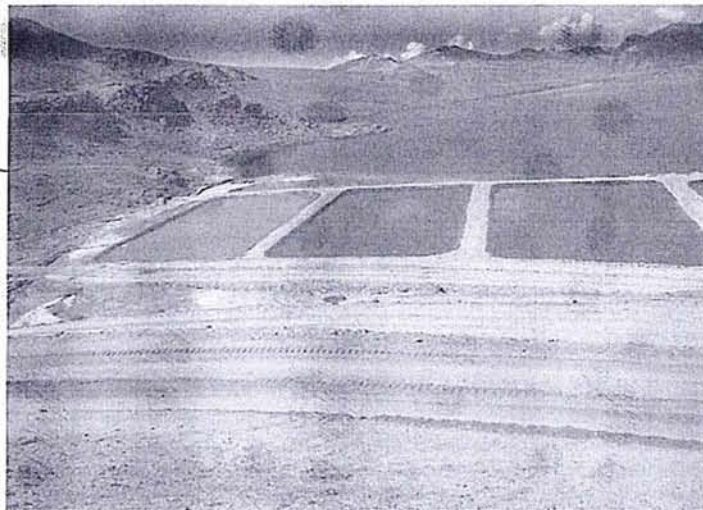
Foto N° 7: Pozas de tratamiento Weilhand que actualmente reciben una parte de las aguas decantadas de la cancha de relaves N° 2 (punto de control P-3) y las aguas servidas del pozo séptico N° 1 (punto de control C-3-1).
