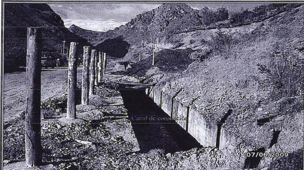
FOTOGRAFIA N° 16.- Obsérvese la ubicación del canal de coronación y la pila de top soil, con respecto al lugar preciso del desacoplamiento de la tubería de agua reciclada.
