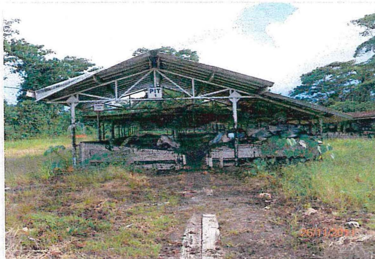
Fotografía N° 3 Vista panorámica del centro de almacenamiento de restos de hidrocarburos en el Yacimiento Corrientes, el cual no cumple con las exigencias de la normativa de residuos sólidos.
