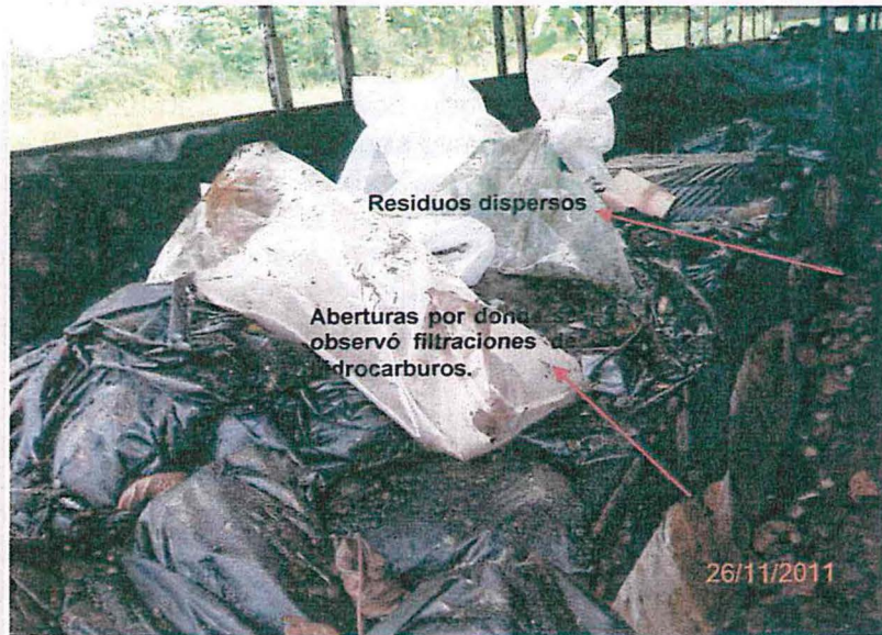
Fotografía N° 4 Centro de almacenamiento de residuos peligrosos del Yacimiento Corrientes donde se observa que no se encuentra impermeabilizado, lo cual permite filtraciones de hidrocarburo al suelo. Asimismo, existen restos de residuos dispersos en el área de acceso a las celdas.
