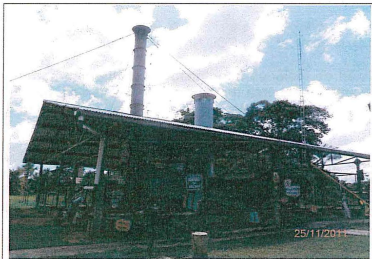
Fotografía N° 2 Vista panorámica del incinerador ubicado en el Yacimiento Yanayacu , el cual durante la supervisión no contaba con sistema de lavado y filtrado de gases .
