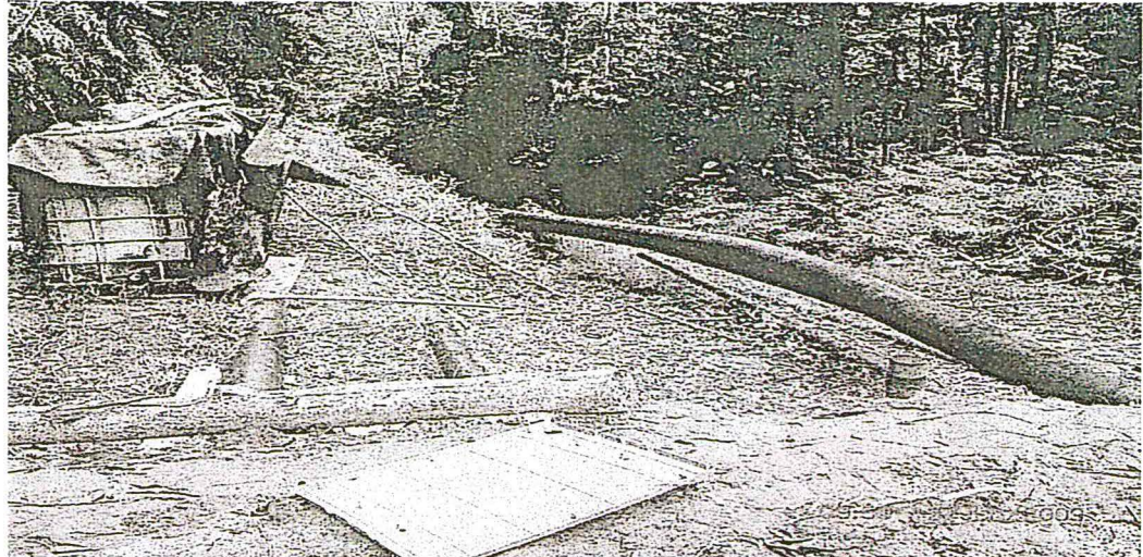
Fotografía N° 2: Muestra líneas de producción, transline y oleoducto que cruzan la Quebrada Pañayacu, convirtiéndola en una zona de alta consecuencia.
