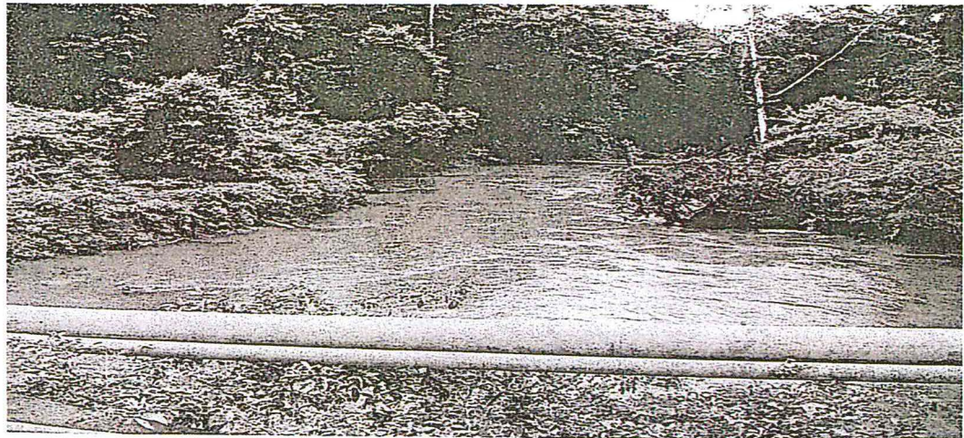
Fotografía N° 3: Muestra líneas de producción, transline y oleoducto que cruzan la Quebrada Pañayacu, convirtiéndola en una zona de alta consecuencia.
