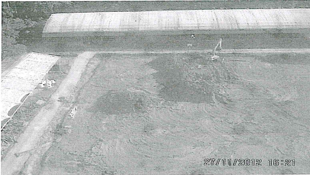
Sumilla: Vista de almacenamiento de los cortes de perforación de base agua después del proceso de tratamiento, en la Locación Situche Norte 4X.
