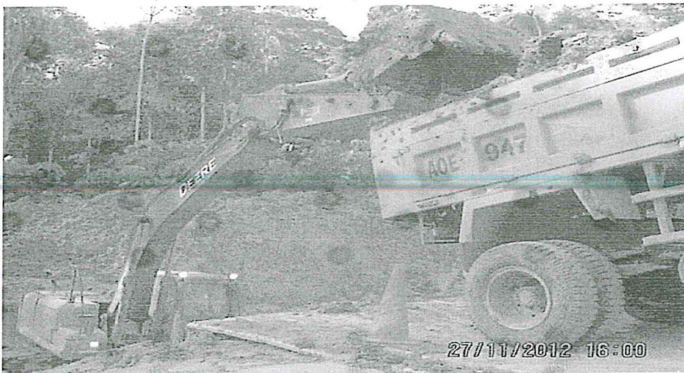
Sumilla: Vista de la disposición final de los cortes de perforación de base de agua en la Locación Situche Norte 4X.
