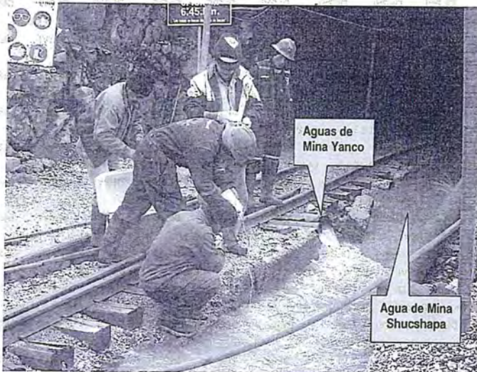
Nota: Obsérvese el vertimiento de Las aguas provenientes de la Bocamina Yanco, que se une al efluente que sale por la bocamina Shucshapa.
