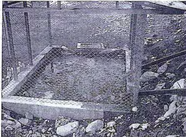
Fotografía N° 24: Vista del lecho de secado de los lodos de la planta de tratamiento de aguas servidas. De la estación E: 16B "Desagüe después del filtro Hidro B" que se descarga hacia la laguna Caballococha
