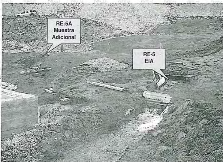
Fotografía N° 41: Vista de los dos efluente proveniente del rebose del sedimentador de la Bocamina Tinquicocha. Por lo que, se recomienda al Titular Minero, unirlos con un canal y luego monitorear en el RE-5: "Descarga de aguas del sedimentador de la Bocamina Tinquicocha", sobre el canal a una distancia entre 5 á 10 m. antes de su ingreso a la Laguna Tinquicocha.
