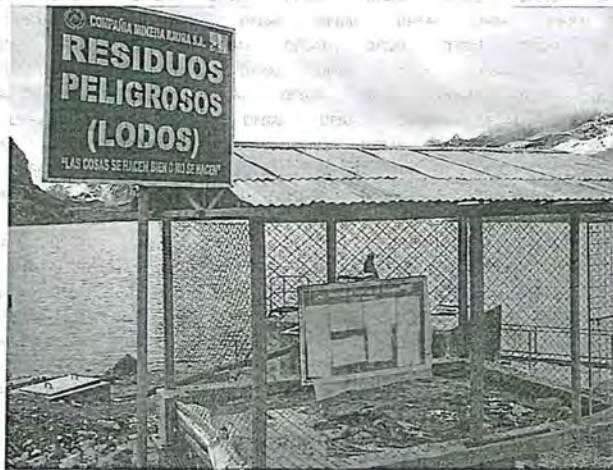
Fotografía N° 17: Vista del lecho de secado de los lodos (residuo peligroso) de planta de tratamiento de aguas servidas de la Estación conocida como Punto de monitoreo E: 16A "Desagüe antes de filtro Hidro A" que se descarga hacia la Laguna Caballicocho, de la Cía. Minera Raura S.A.
