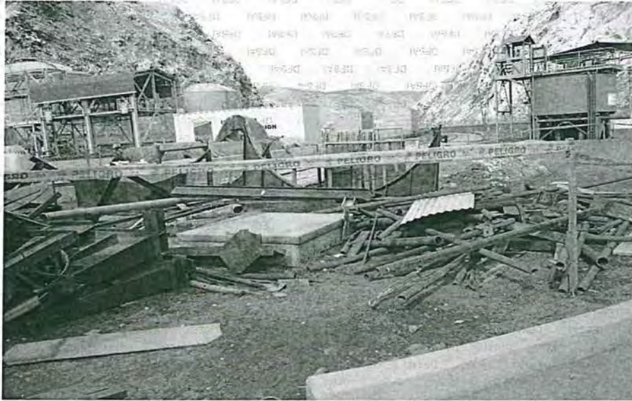
FOTO N° 5: Acumulación de chatarra oxidada sobre un área verde que se encuentra colindante a la planta de almacenamiento de ácido sulfúrico y la zona de lavado de llantas de vehículos.
