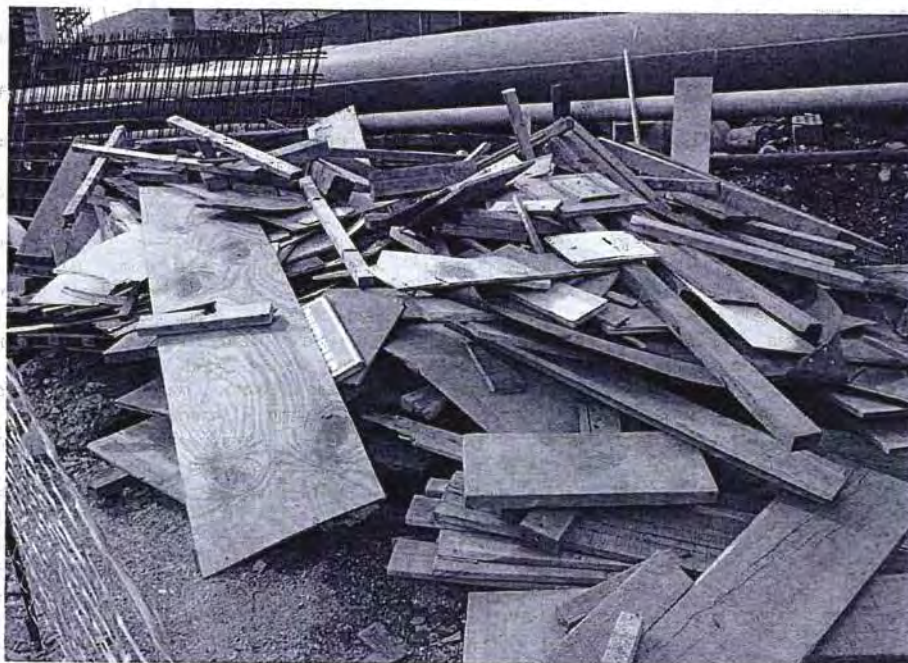
FOTO N° 9: Maderas usadas dispuestos sobre suelo natural, situado entre la zona de lavado de llantas de vehículos y la tubería de agua de TISHGO.
