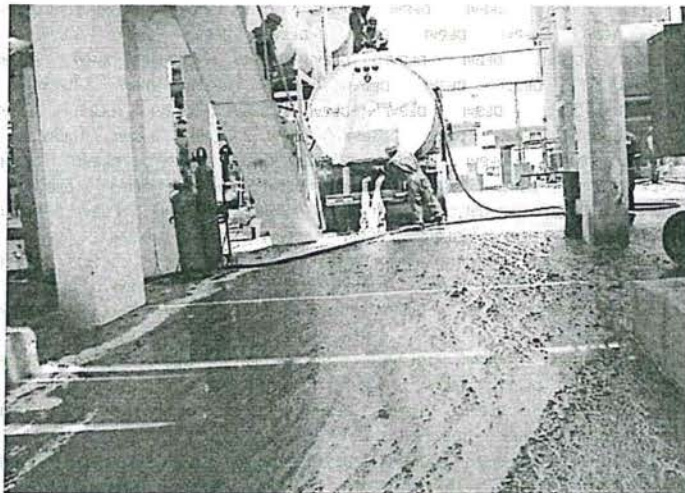
Foto N° 8: Lavado de la parte interna del tanque del carro cisterna.
