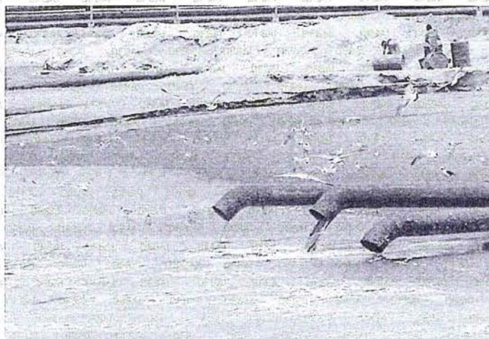
Foto N° 12 Emisor (tubería) de Cridani arrojando efluente sin tratamiento producto de limpieza de sus equipos.
