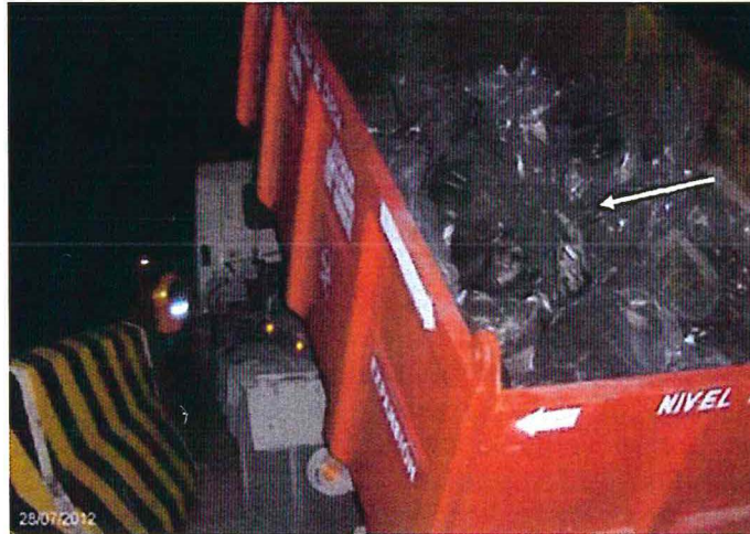
Fotografía N° 30: Carguío inadecuado de los residuos peligrosos.
