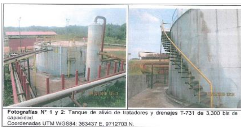
Figura 3. Vista del Tanque 731 49 .
