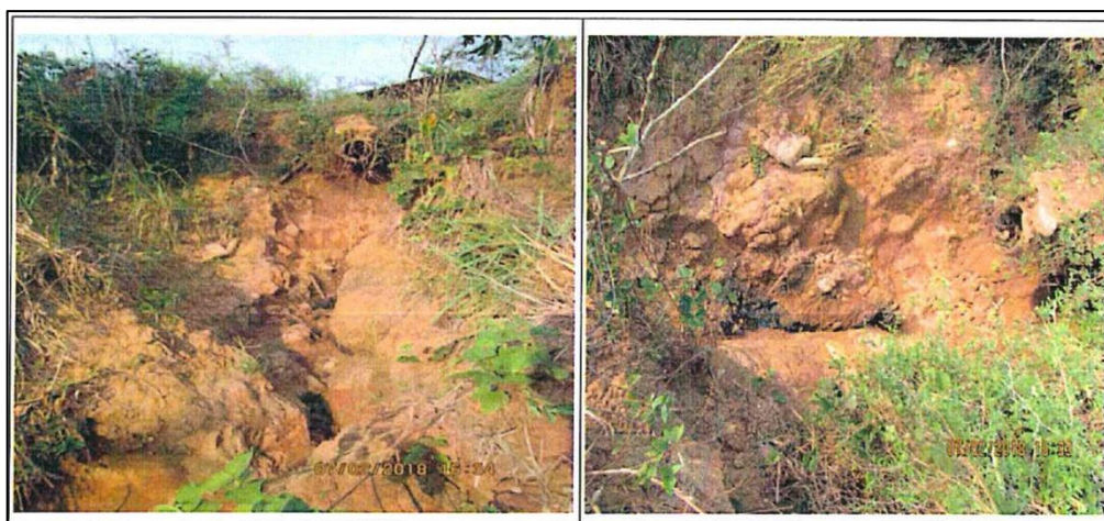
Figura 5. Suelo del punto de descarga del buzón exterior impactado con hidrocarburos.
