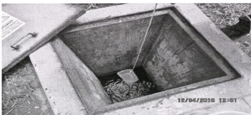
FOTO N° 02: Toma de muestra de agua residual industrial.
