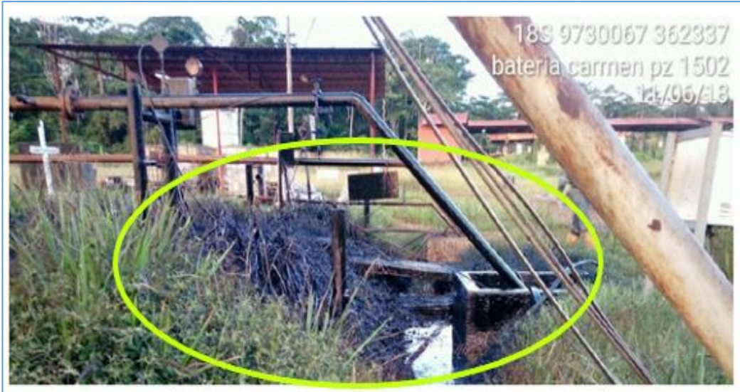
Figura 1. Fuga de fluido de producción en el Pozo 1502
